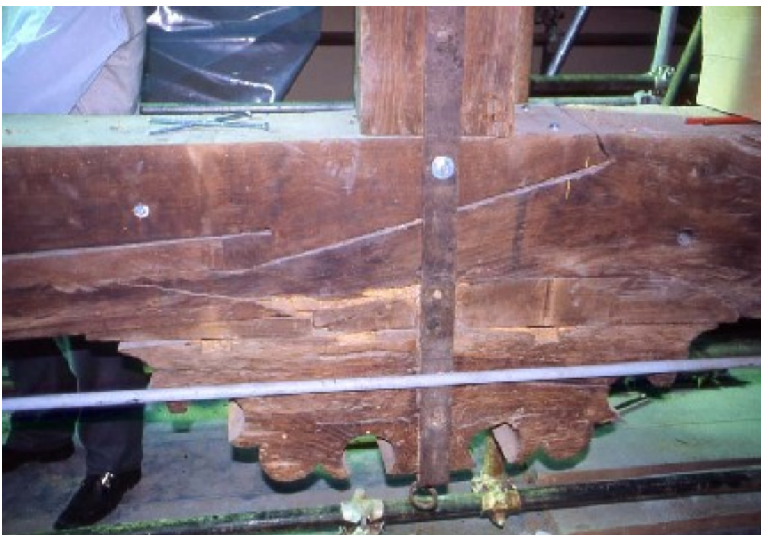
L'apparecchio di sostegno e rimando in luce.
