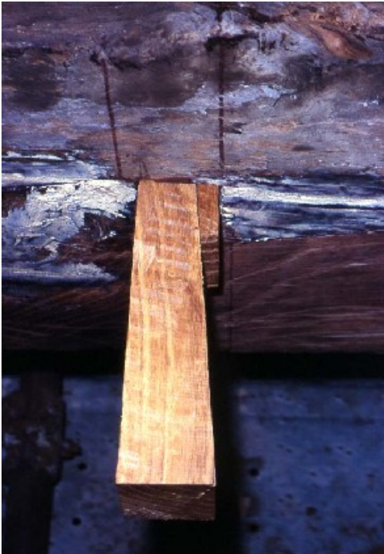
Realizzazione delle chiavi con doppio cuneo.
