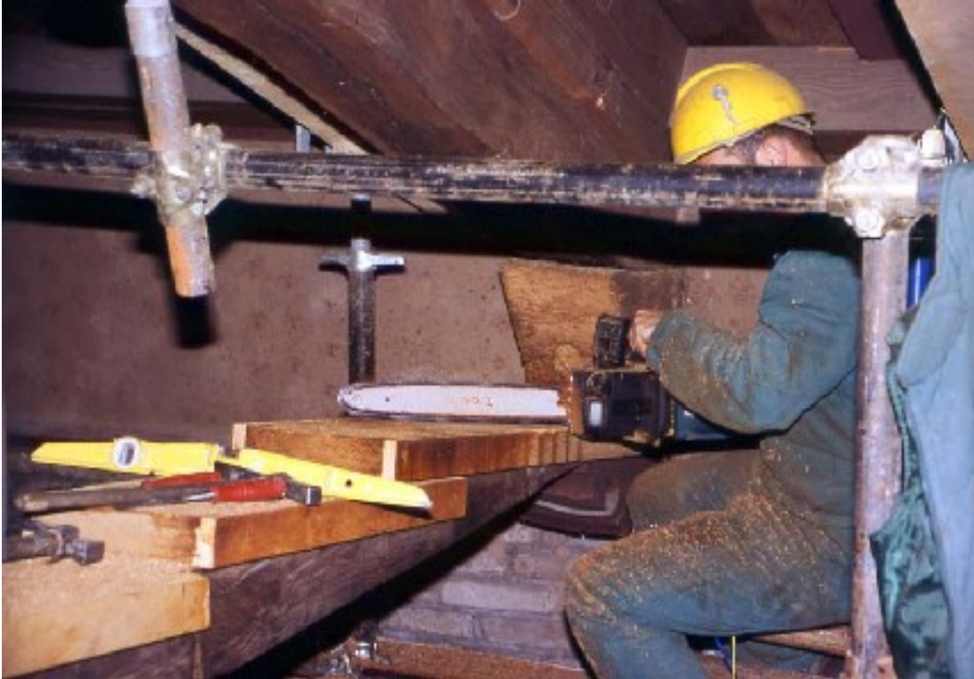
Realizzazione dell'indentatura sulla catena.
