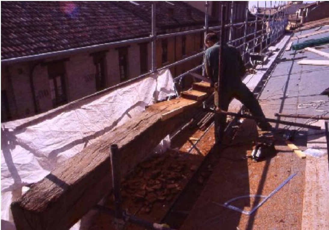
Preparazione della protesi sul tetto di una navata laterale.
