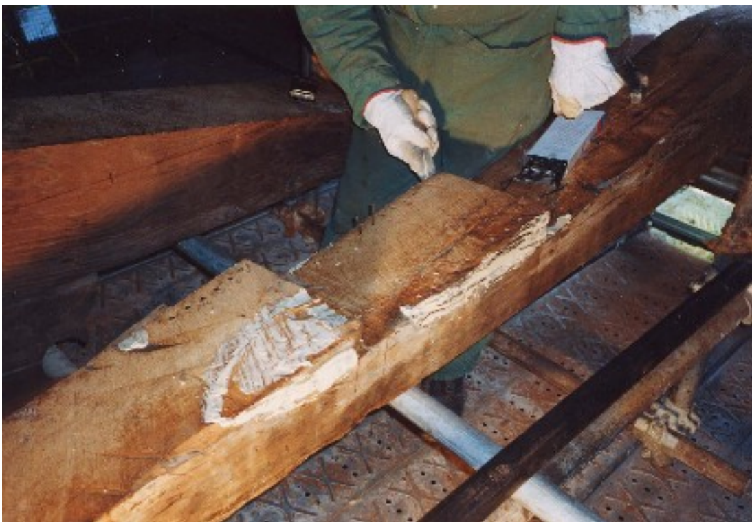
Incollaggio e chiodatura delle parti distaccate in corrispondenza delle dentature.
