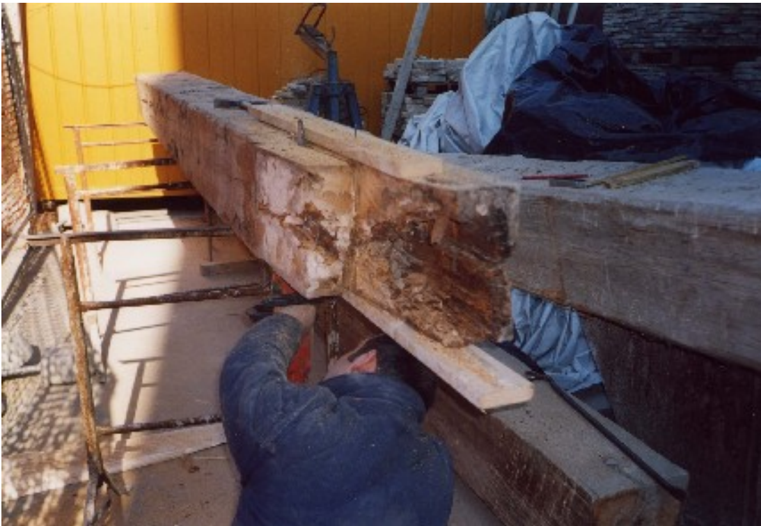
Preparazione dell'estremità del puntone.
