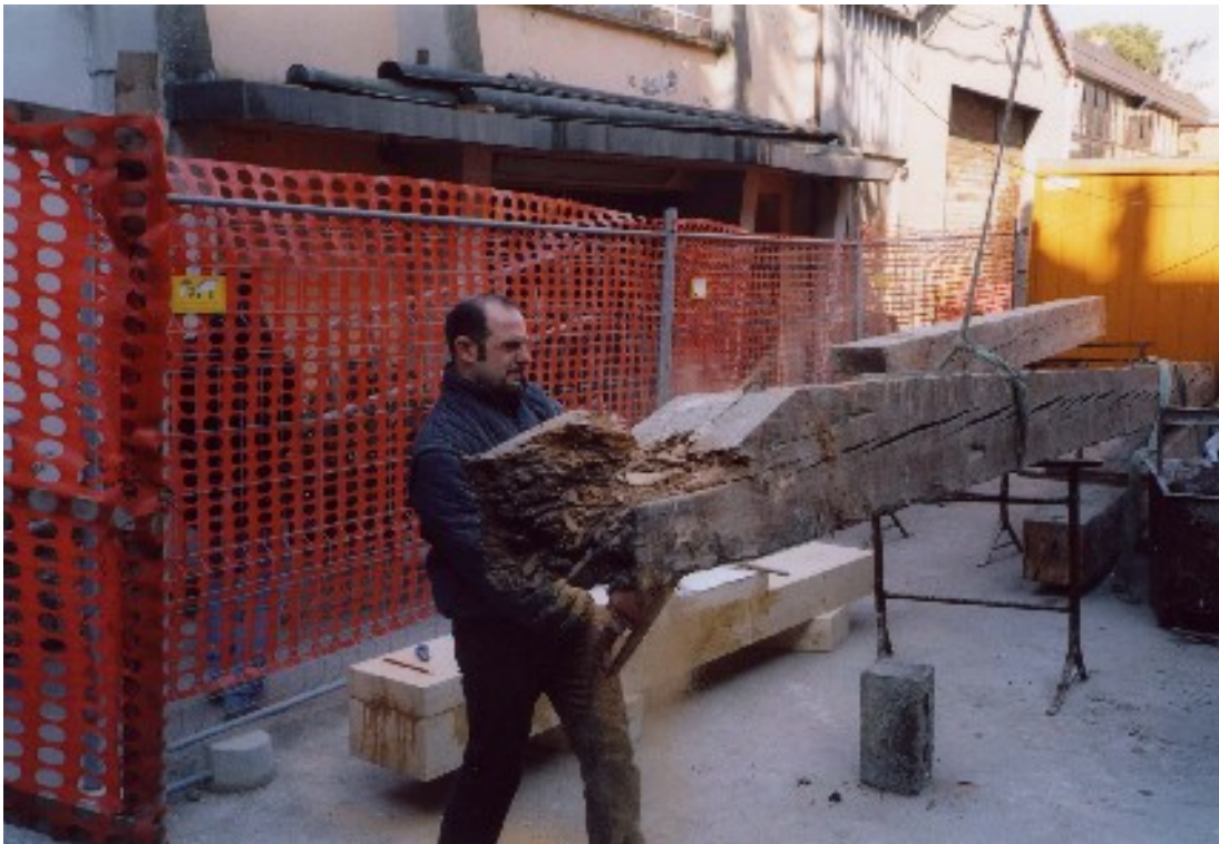
Preparazione della catena.
