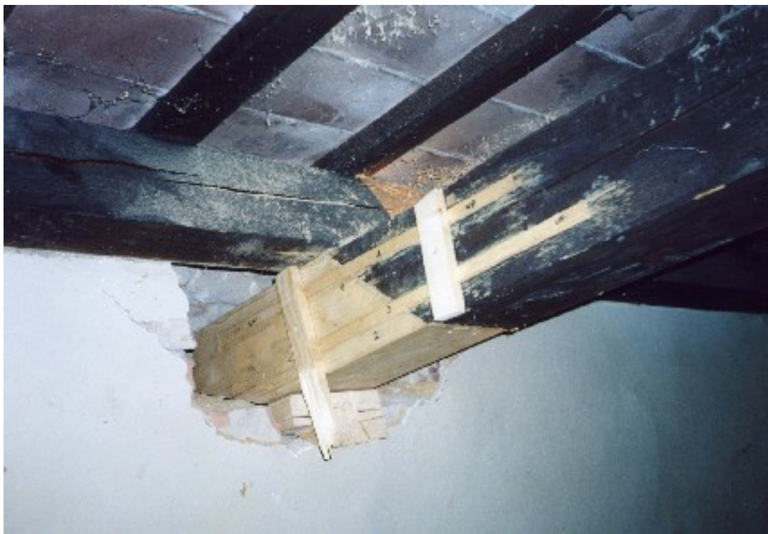
Serraggio dei listelli di chiusura dopo l'incollaggio.
