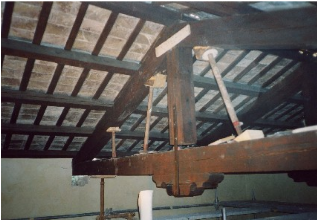
Puntellazione della capriata e rimessa in geometria.
