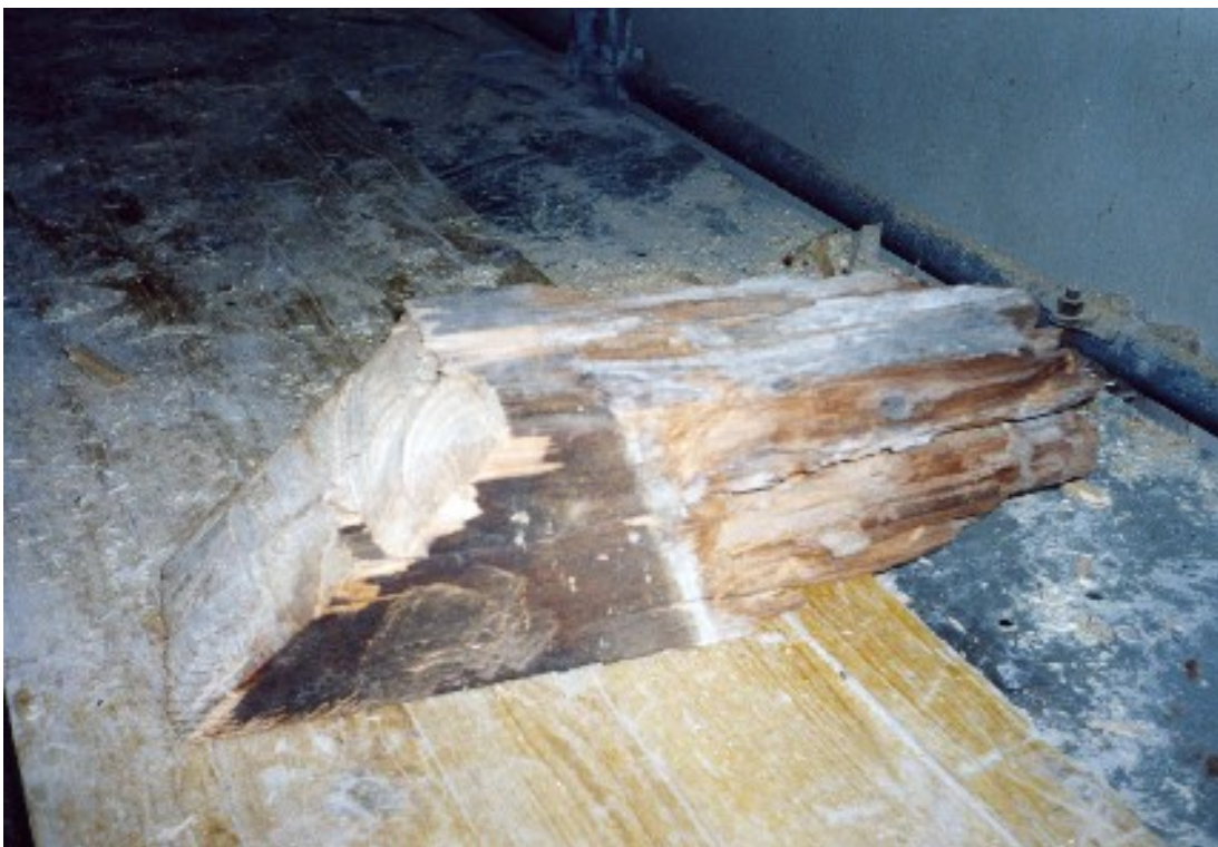
Una testata cariata rimossa.
