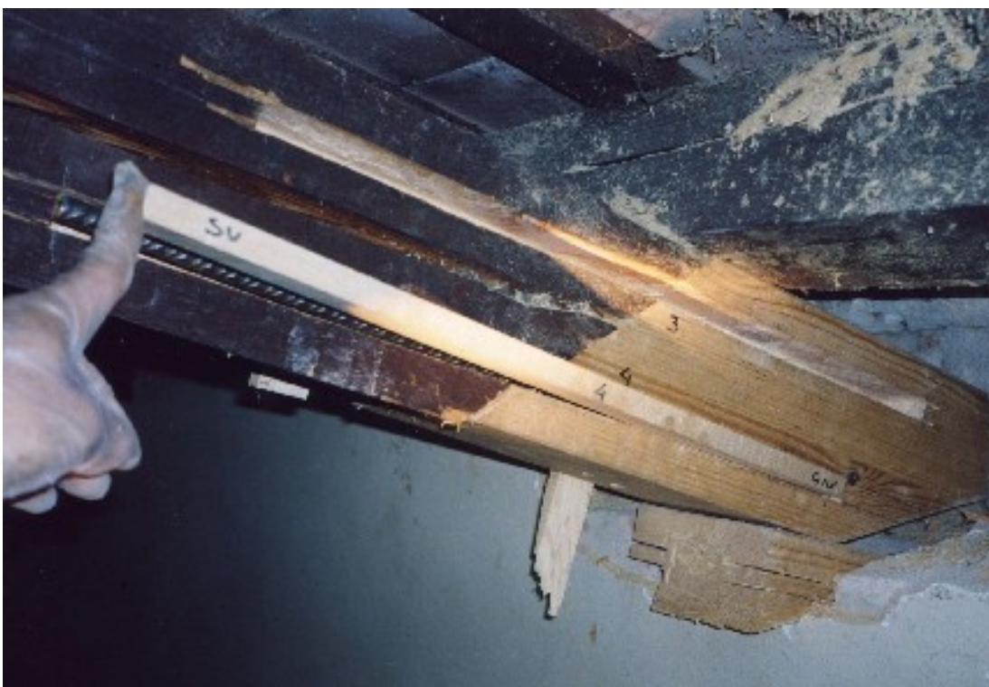
Presentazione delle barre di unione e dei listelli di chiusura prima dell'incollaggio.
