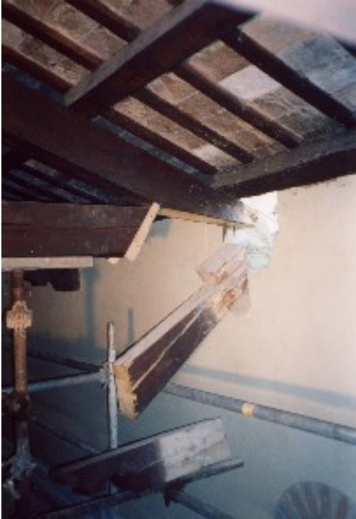
Taglio e rimozione della parte cariata.
